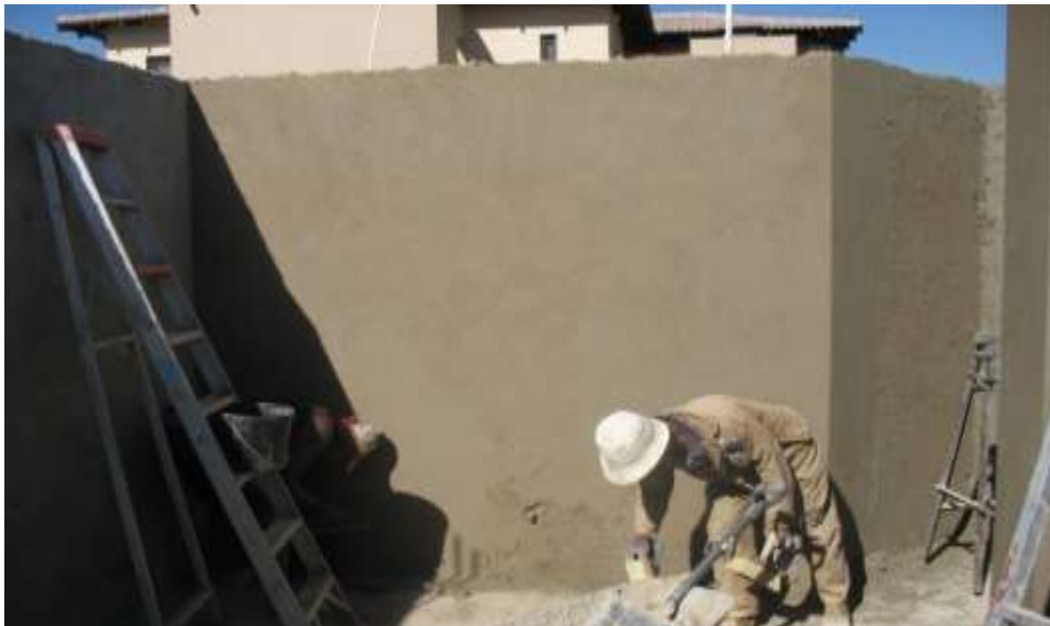
11. Final – Aplicação de reboco às paredes de argamassa
