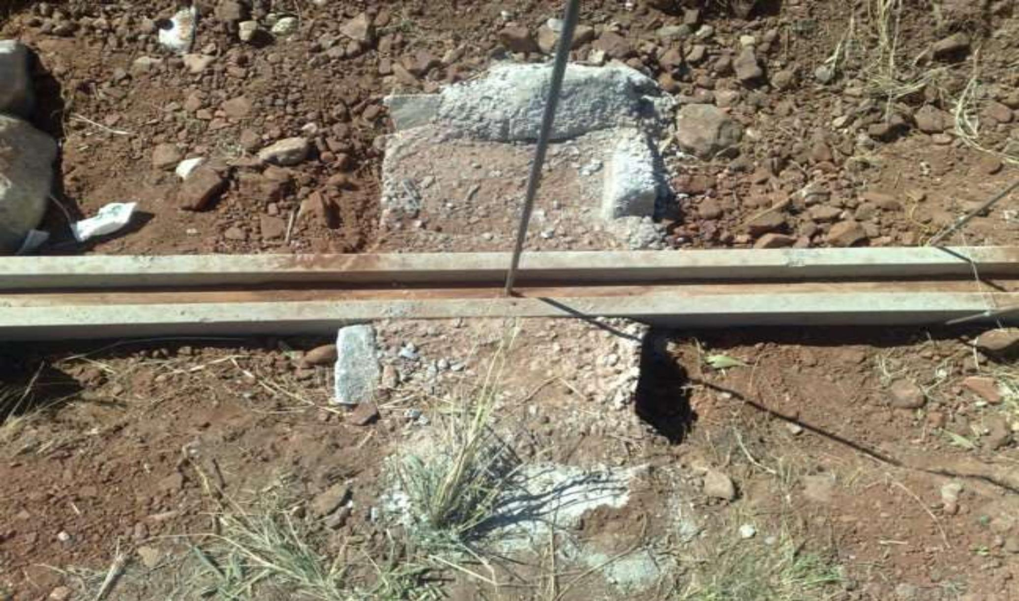
Viga apoiada nos plintos de fundação
