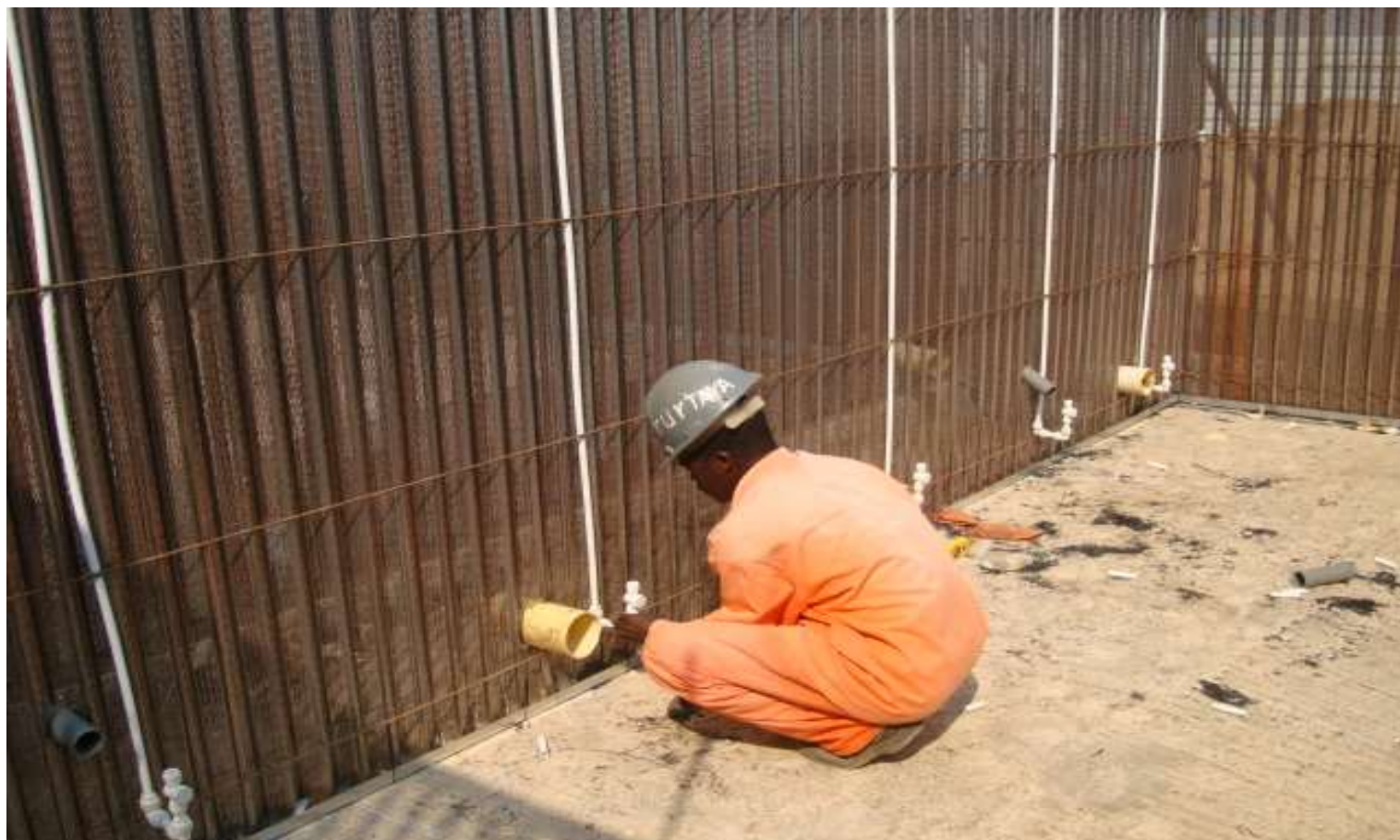
7. Installation des conduites de plomberie
