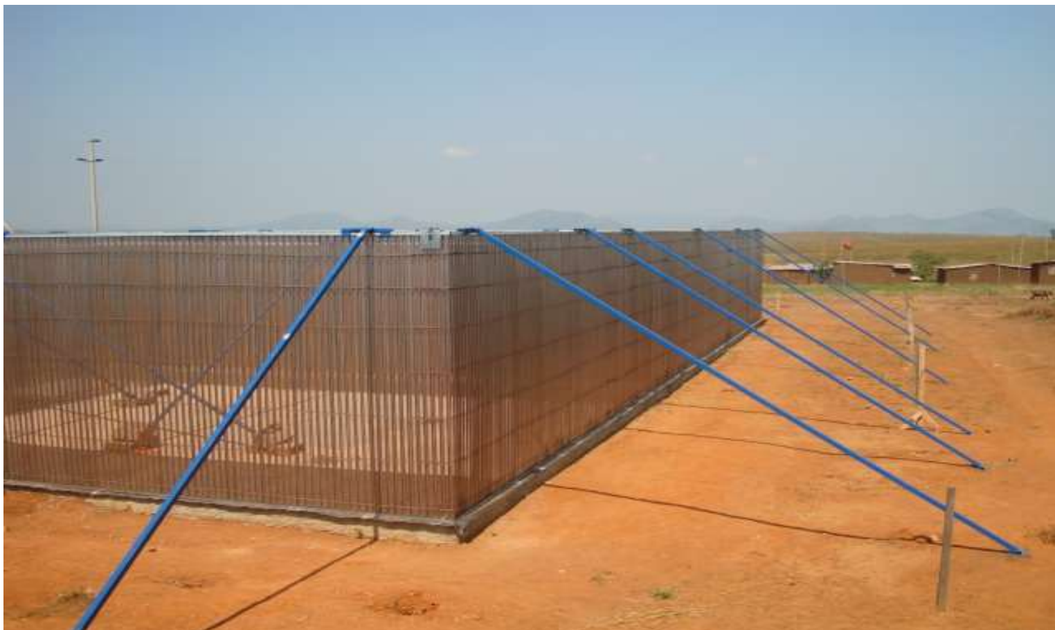
5. Erection des parois murales
